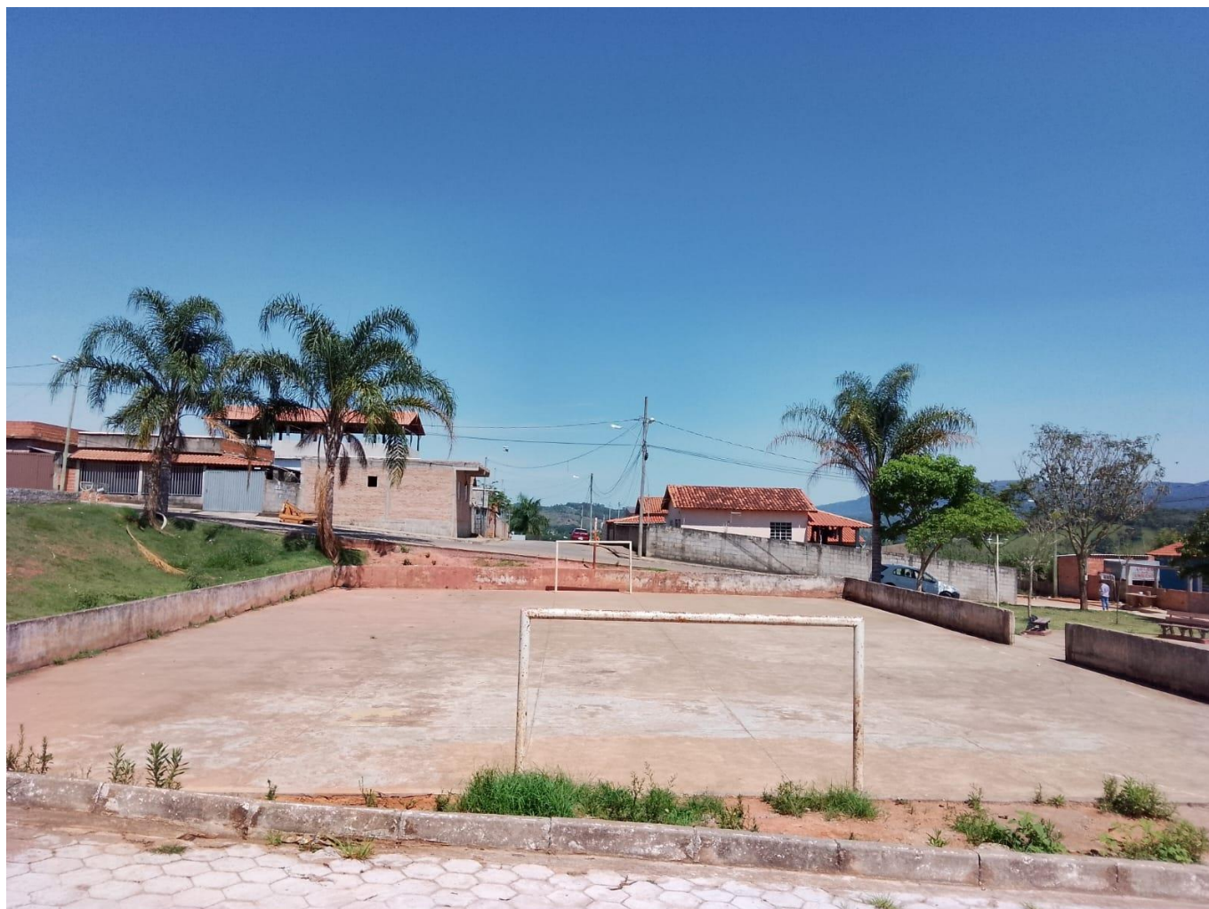
Figura 2: Local da Cobertura da Quadra
