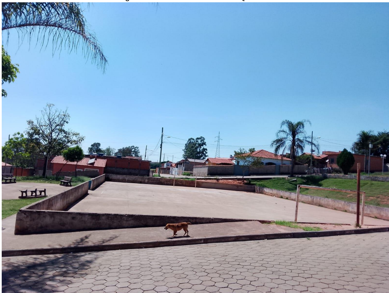
Figura 4: Local da Cobertura da Quadra
